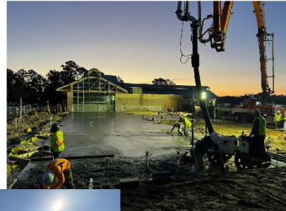
“Lower” Slab Pour
